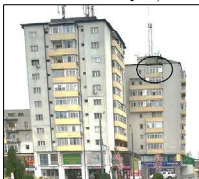
Blocul 92 din centrul orașului, fostul studio al TVV
