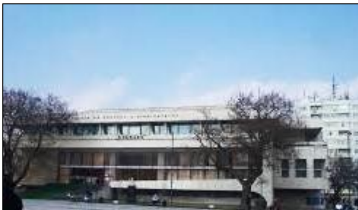
Casa de cultură Vaslui
